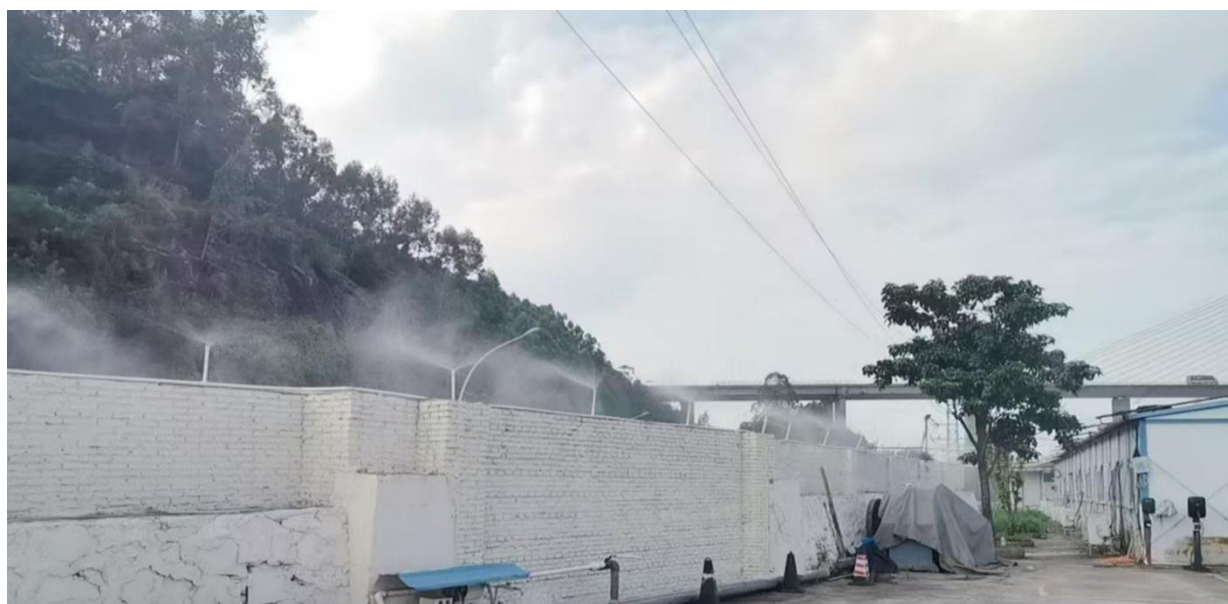
图 3-7 厂区围墙洒水降尘实景图
